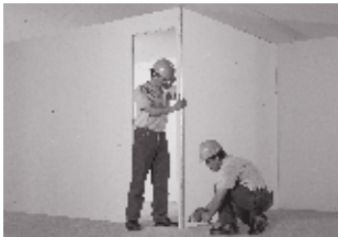
Instalación de ángulo esquinero
