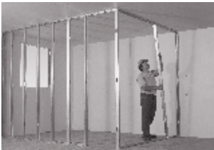
Instalación del montaje
