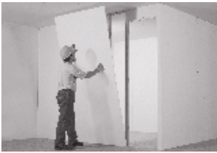
Colocación de revestimientos
